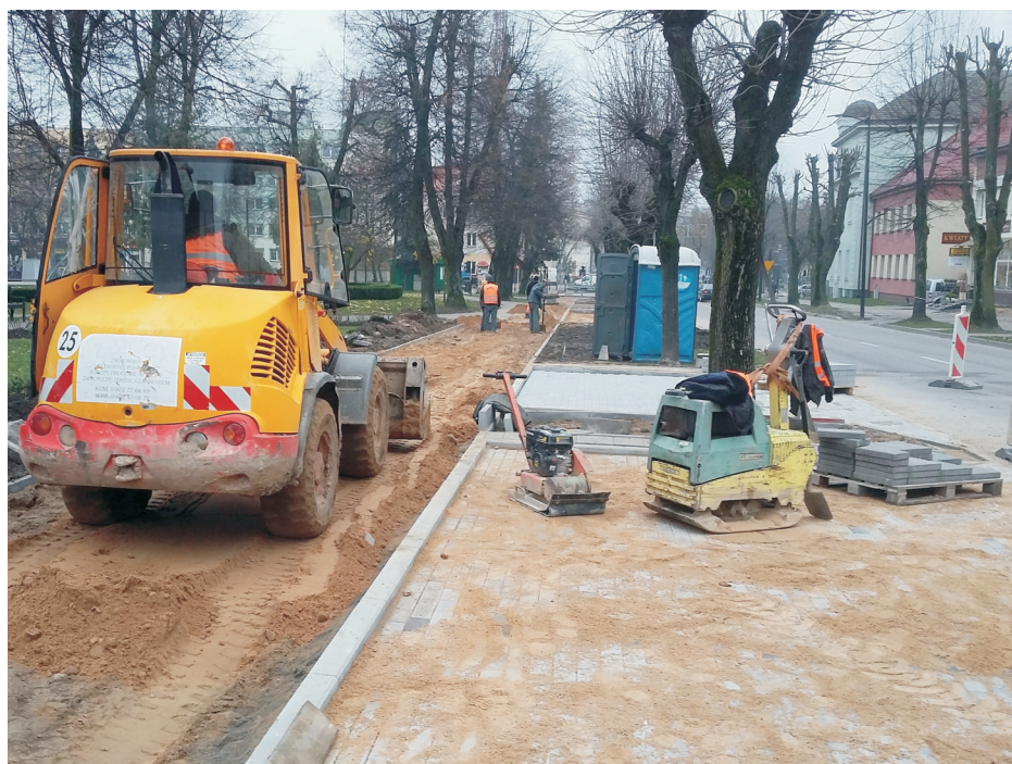
Wykonanie miejsc parkingowych przy ulicy 3 Maja.
