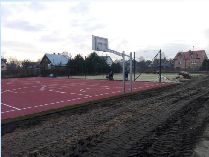
w trakcie realizacji
