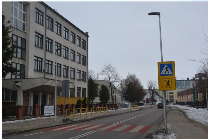
ul. Widowska (oświetlenie) – po realizacji
