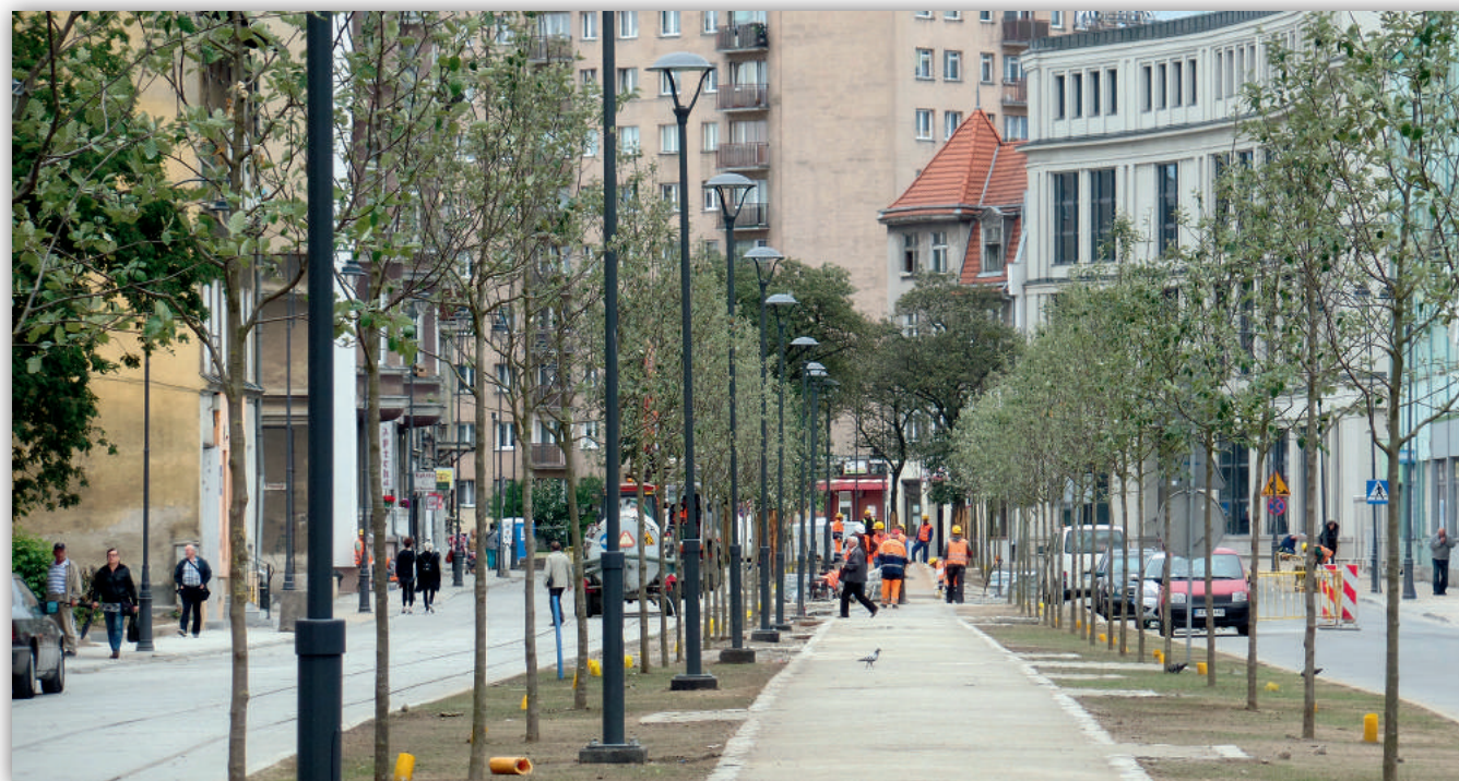
Ulica Łąkowa w ostatniej fazie przebudowy.
