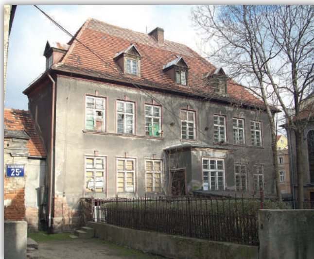
Budynek przed remontem.
