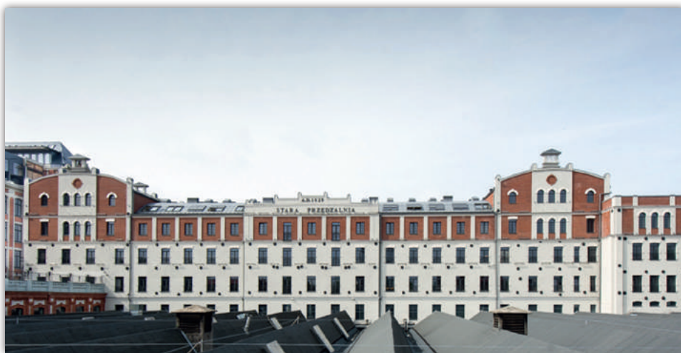
MOPS i CAL w wyremontowanym budynku.
