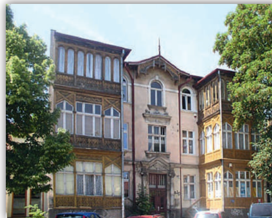
Kamienica w centrum Sopotu przed remontem. Foto: Urząd Miasta Sopot
