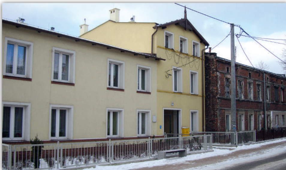
Budynki mieszkalne: wyremontowany i niewyremontowany.
