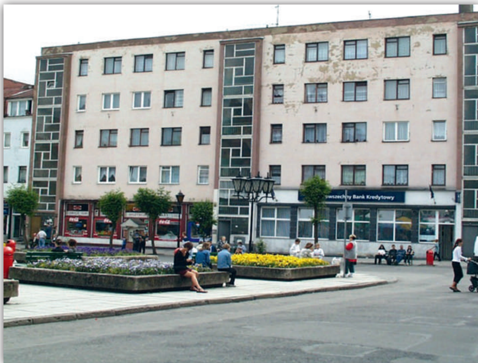
Blok mieszkalny w południowej pierzei rynku (przed remontem).
