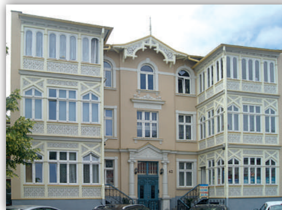
Kamienica w centrum Sopotu po remoncie. Foto: IRM
