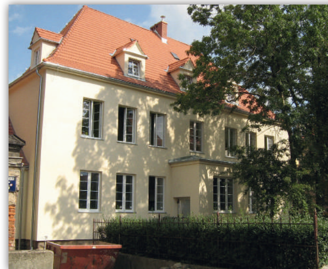
Foto: UM w Wałbrzychu MOPS i CAL w wyremontowanym budynku. Foto: UM w Wałbrzychu
