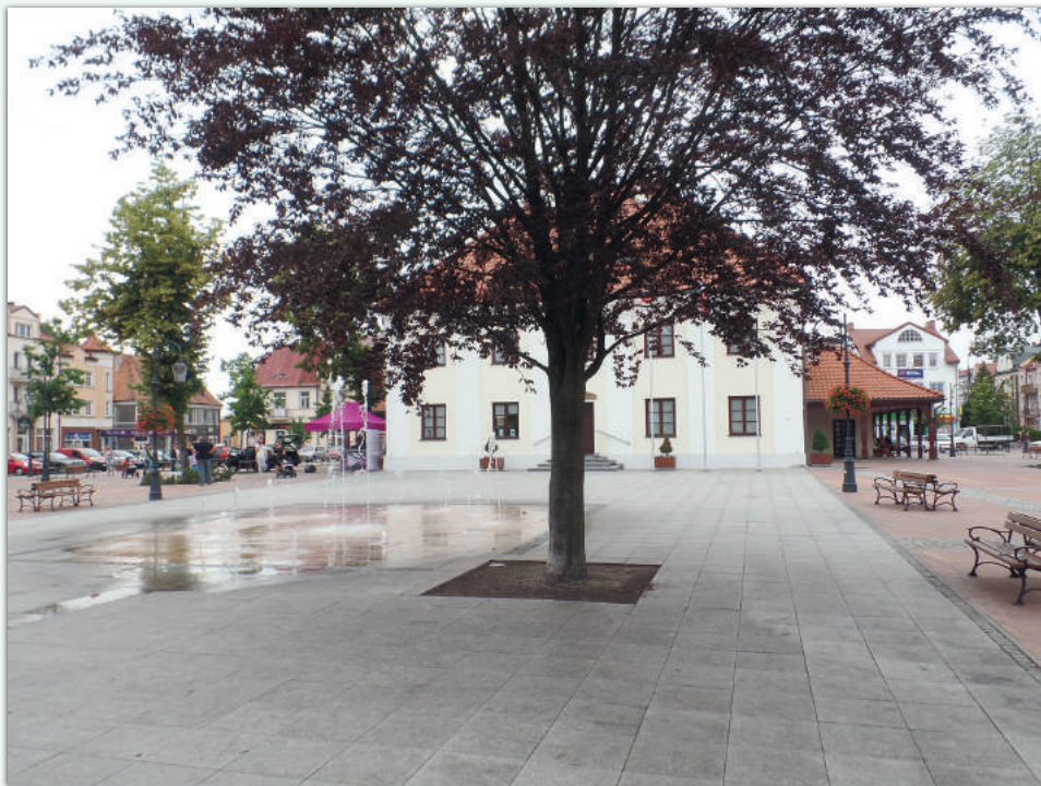
Wyremontowany ratusz na rynku w Przasnyszu.
