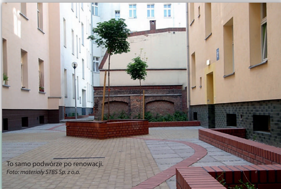
Podwórze przed renowacją. Foto: materiały STBS Sp. z o.o
