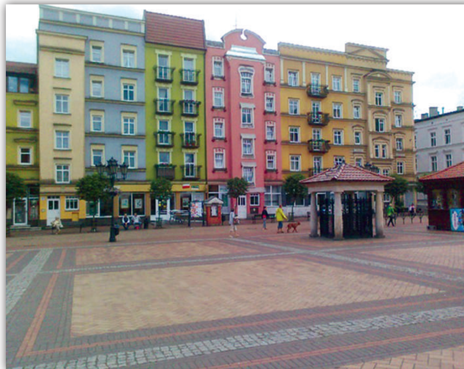
Blok mieszkalny w południowej pierzei rynku (po remoncie).
