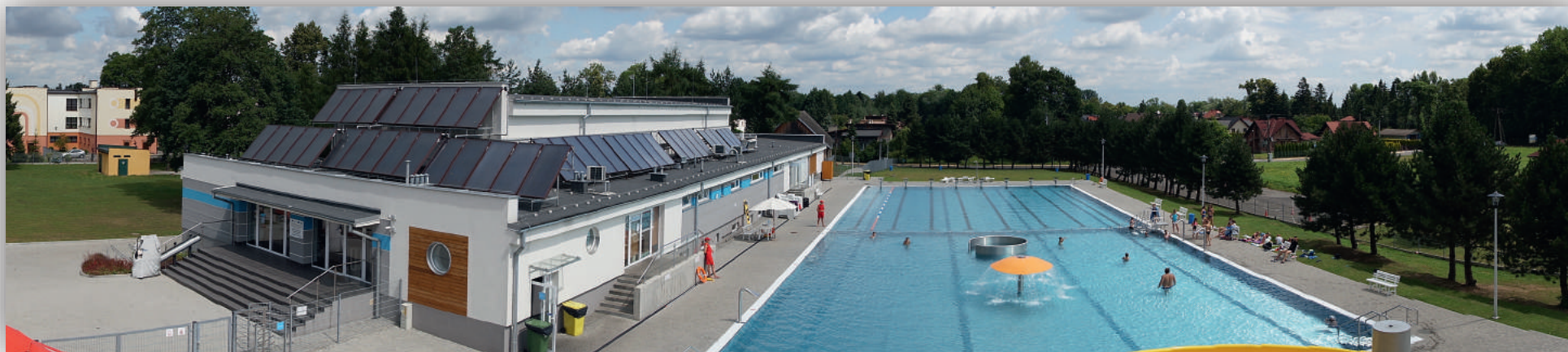
MCKiR po remoncie.
