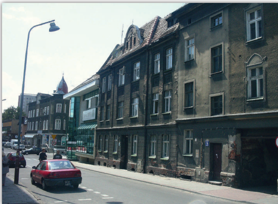
Kwartał A, ulica Limanowskiego 1 przed przebudową.
